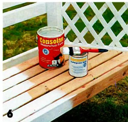
Для защиты от воздействия внешних факторов готовое сооружение покрывают водоотталкивающими и декоративными составами.
