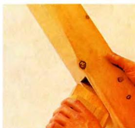
Стойки каркаса, продольные балки и стропила можно соединить врубкой вполдерева.
