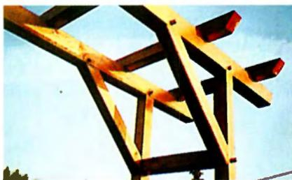
Жёсткость конструкции перголы обеспечена поперечинами, распорками и подкосами, зафиксированными шипами с клеем и шурупами.
