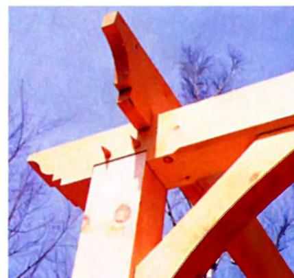
Выпилив пазы в стропилах, крепят их к балкам 12-мм шурупами. Подкосы обеспечивают жёсткость.
