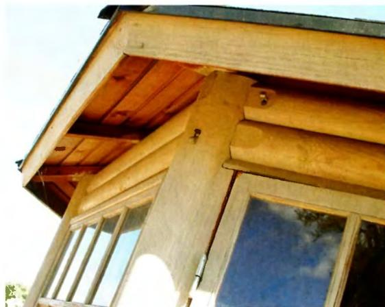
Сплошная обрешётка крыши будет выполнять одновременно и функцию потолка. Поэтому монтаж ведут строганой стороной вниз. Два бревна над окнами обеспечивают дополнительную жёсткость и устойчивость стен.
