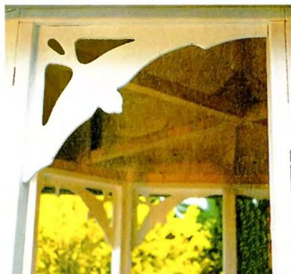
В данном случае фигурный подкос нужен не для прочности конструкции — это всего лишь элемент украшения.
