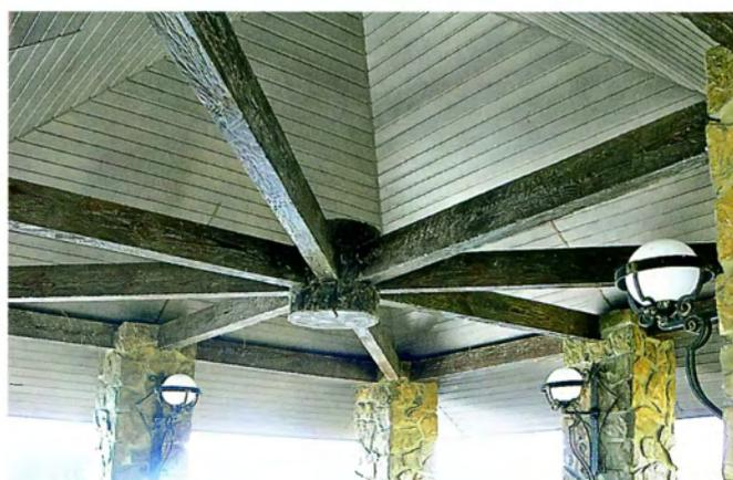
Затяжки каркаса крыши соединены в центре, как спицы колеса от телеги в ступице, что смотрится очень эффектно.
