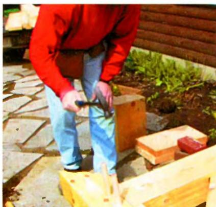
Нагели Ø 25 мм забивают в заранее просверленные отверстия и прочно скрепляют балки со стойками.
