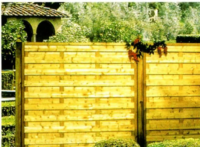
Эти заборы — ветровые экраны — сделаны в виде отдельных секций 1,8 × 1,8 м с двусторонней обшивкой тонкими досками или полосами влагостойкой фанеры.
