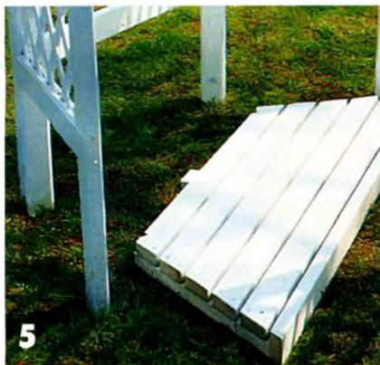
Две собранные трапециевидные скамейки крепят к стойкам шурупами-саморезами. Бруссы сиденья сколочены с зазором 10 мм.
