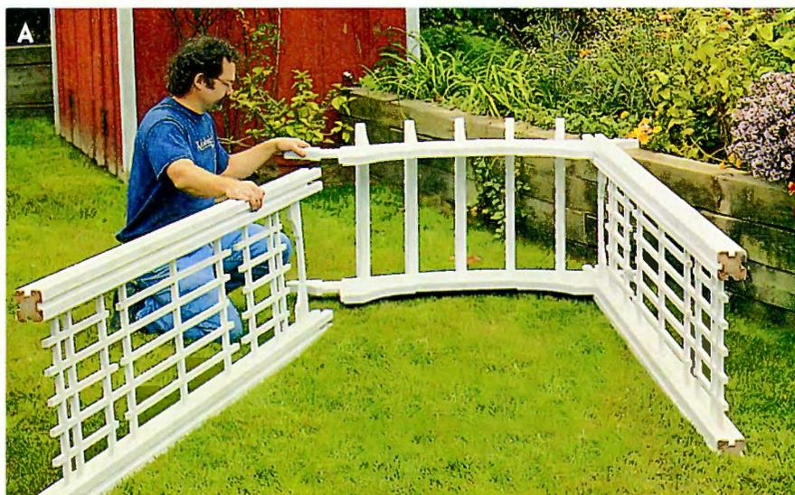
Конструкция состоит из трёх частей: двух боковых решётчатых стенок и верхней перемычки. Арочные перемычки входят в пазы на концах стоек, в результате получается надёжное разборное соединение без шурупов или другого крепежа.
