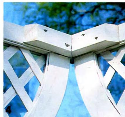
В углах, в которых соединяются дугообразные элементы, верхнюю обвязку усиливают накладными брусками, запиленными на ус.
